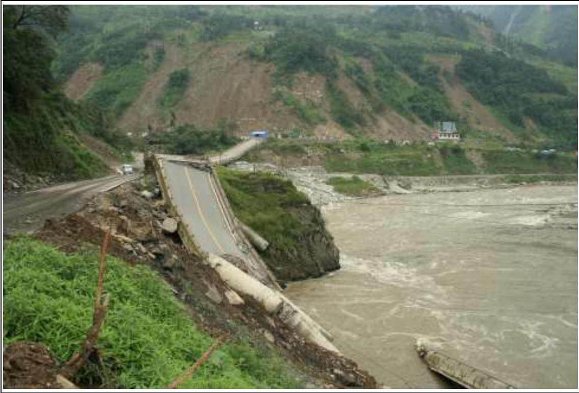
B6: 白花大桥 fell into 白水河.
