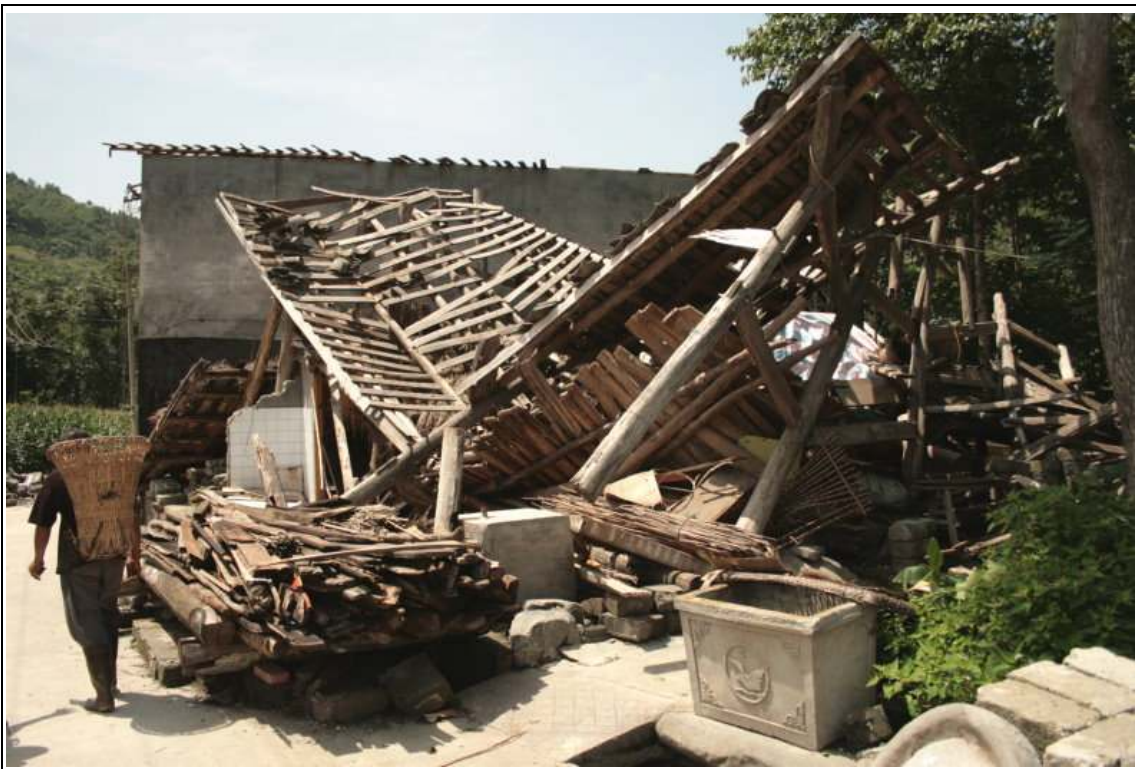
E7: 平通鎮 – Collapsed houses.
